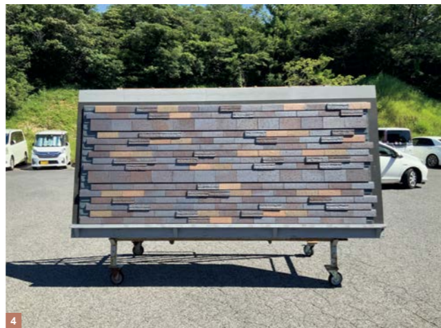
1 2 3 4 LIXILの工場で作ったモックアップをつくり、時間や角度を変えてタイルの見え方をチェックしながら割付を検討していった（資料提供：4点とも大成建設）
