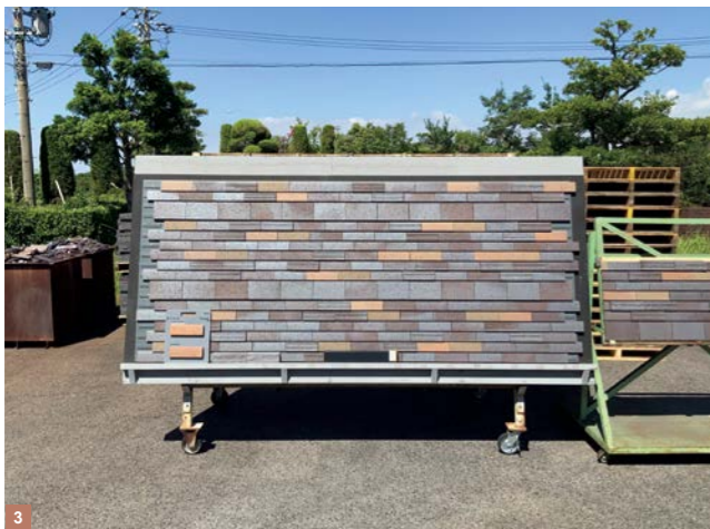
1 2 3 4 LIXILの工場で作ったモックアップをつくり、時間や角度を変えてタイルの見え方をチェックしながら割付を検討していった（資料提供：4点とも大成建設）
