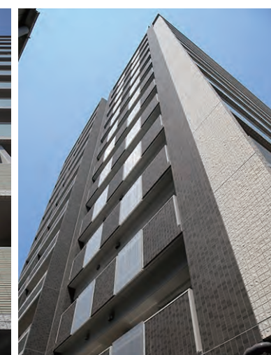
外装壁面 見上げ
