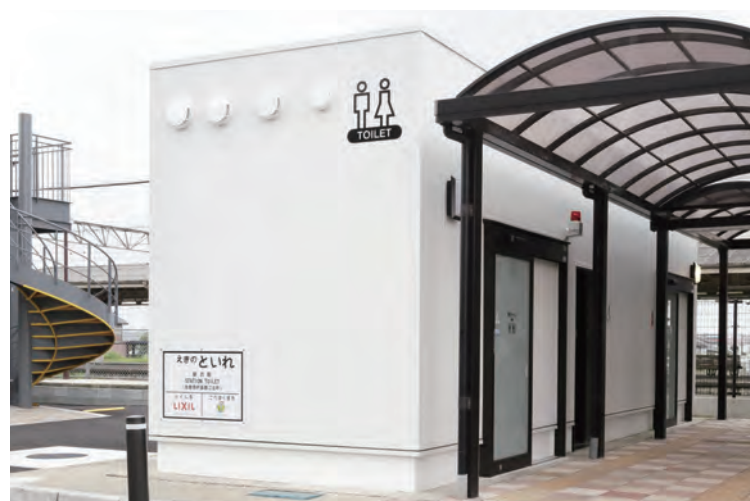
建物の壁面にはモノクロのシンプルなトイレサインと、駅名表示板を模したトイレサインを設置。それぞれのトイレの入り口に、室内の設備をピクトグラムでわかりやすく表示している。異常を知らせる表示灯はバリアフリースイートイレ内の緊急呼び出しボタンと連動し、万が一に備えている。
