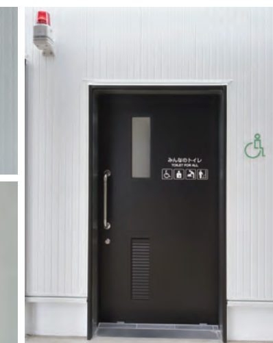
建物の壁面にはモノクロのシンプルなトイレサインと、駅名表示板を模したトイレサインを設置。それぞれのトイレの入り口に、室内の設備をピクトグラムでわかりやすく表示している。異常を知らせる表示灯はバリアフリースイートイレ内の緊急呼び出しボタンと連動し、万が一に備えている。
