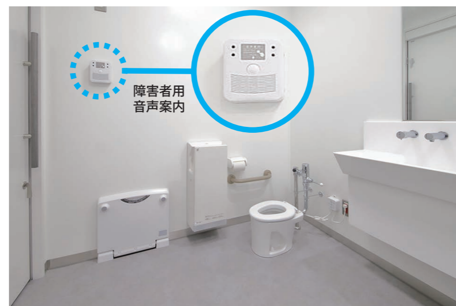
2F バリアフリースイートイレ 幼児用大便器、チェンジングボード
