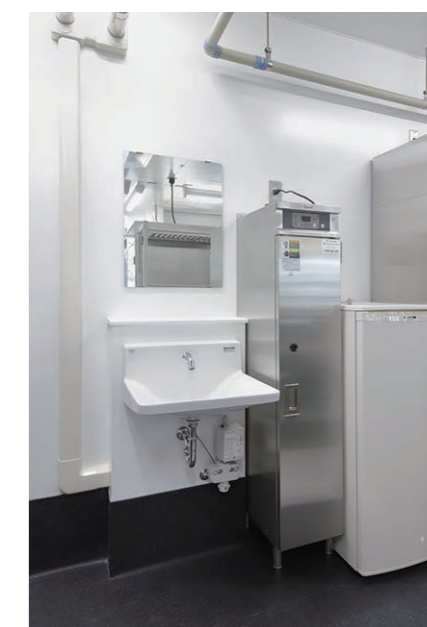
3F 厨房 洗面器
