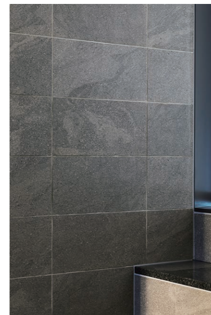
階段 内装壁面
