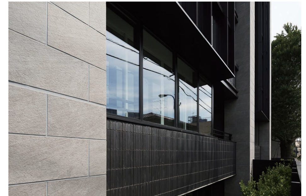
外装壁面 低層部
