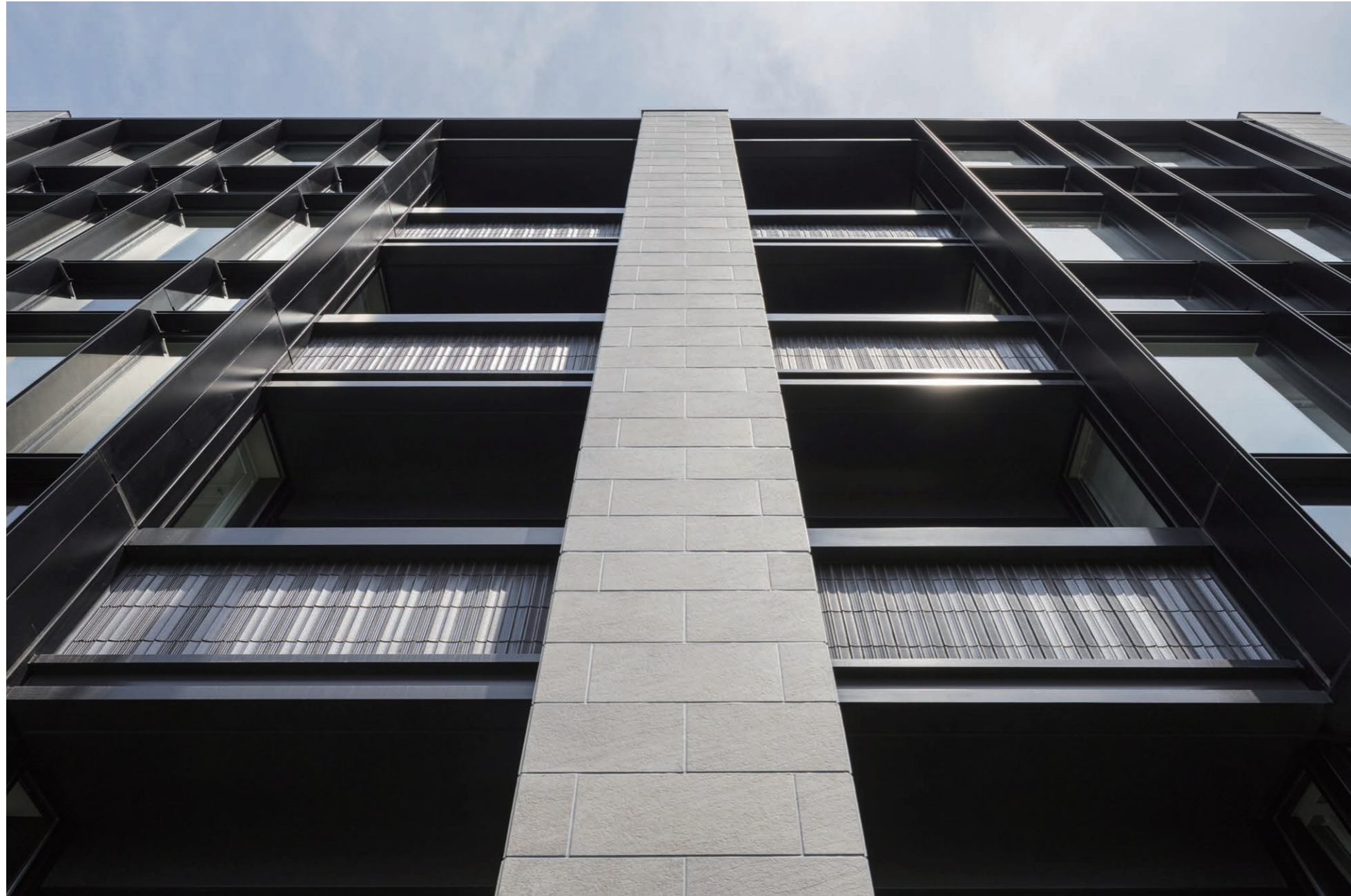
外装壁面 見上げ
