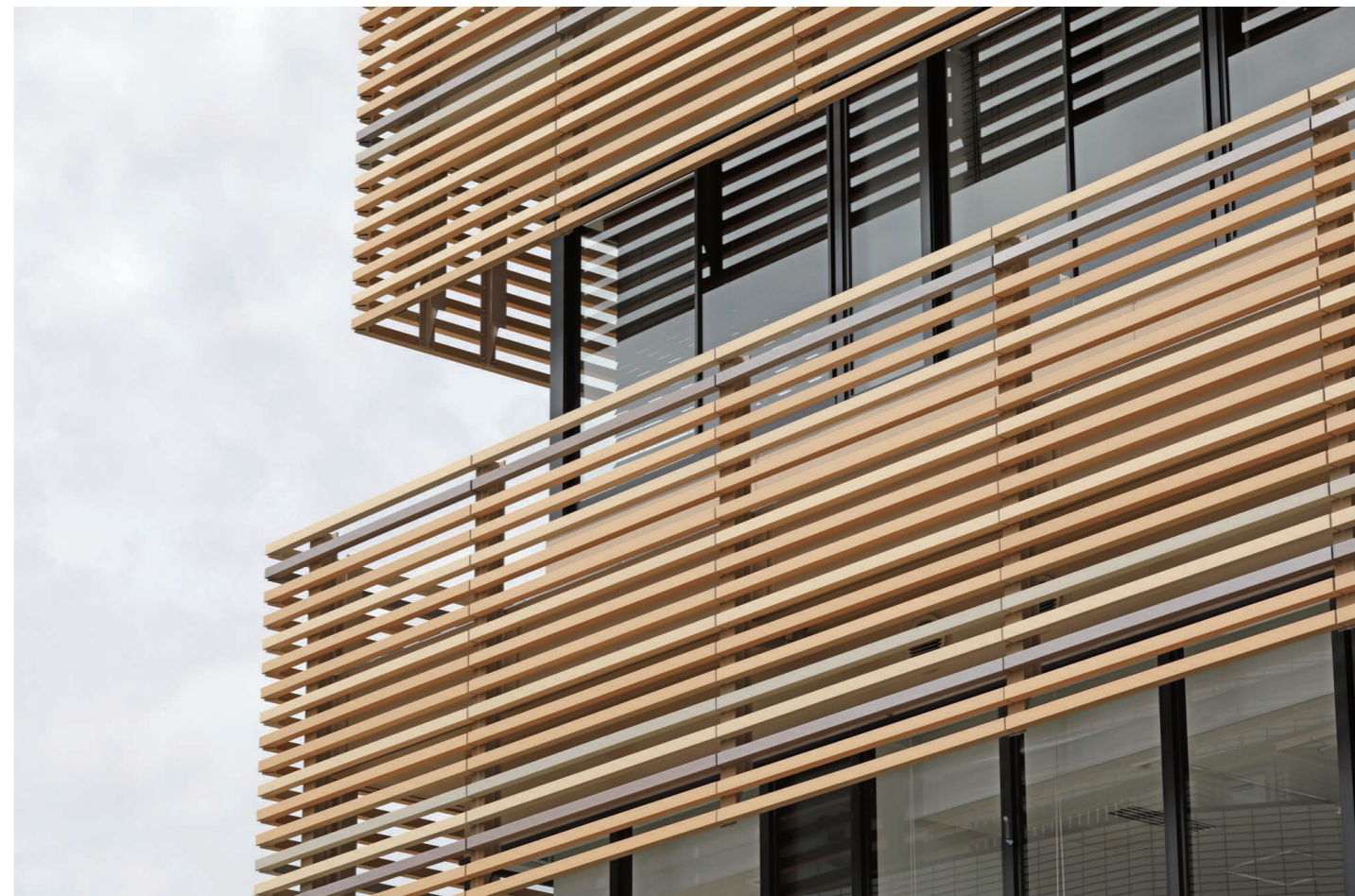
伝統的な織物『双子織』の特徴的な配色を4色のテラコッタルーバーで表現
