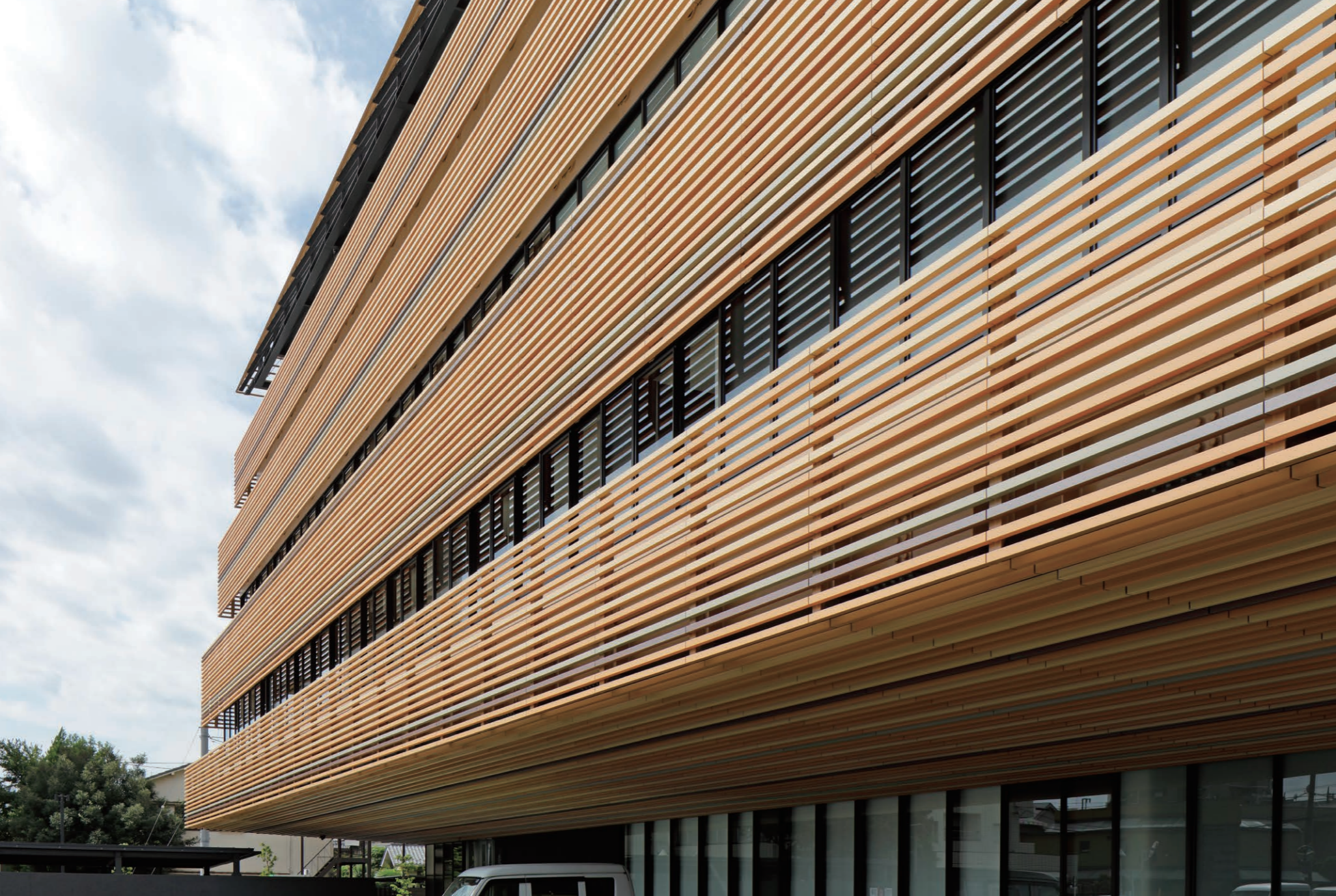
テラコッタルーバーは外壁側面に取り付けて更に軒下に吊り下げて施工。テラコッタルーバーは水平方向に一直線上に美しく設置されている。
