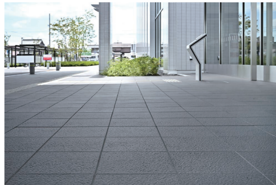
エントランス 外装床タイル
