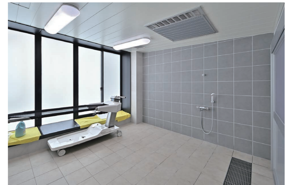
機械浴室 内装壁タイル・内装床タイル
