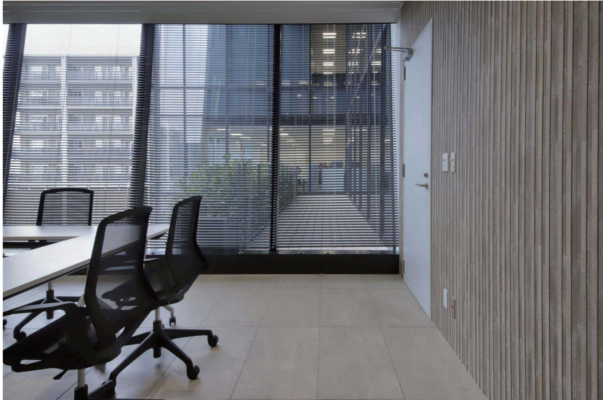
ミーティングルーム 内装壁タイル・内装床タイル
