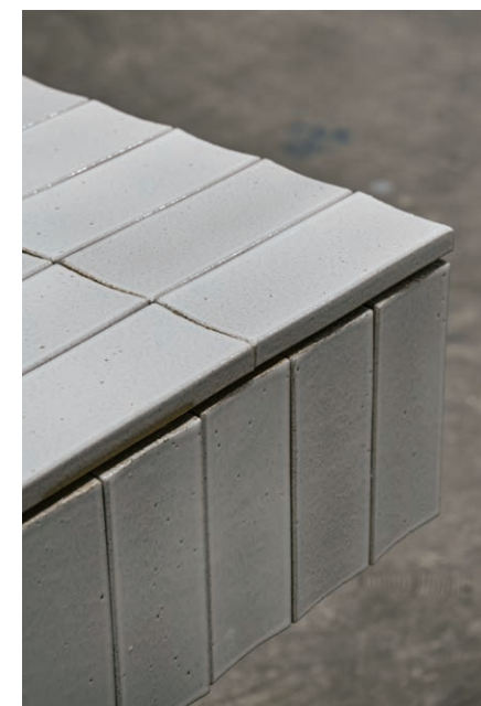
内装壁タイル(カウンター出隅)
