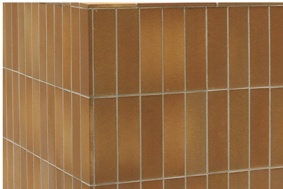
内装壁タイル(メガネ売り場カウンターコーナー部)
