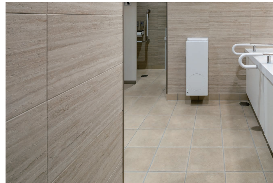
光の庭周り 女性用トイレ 内装壁・床タイル
