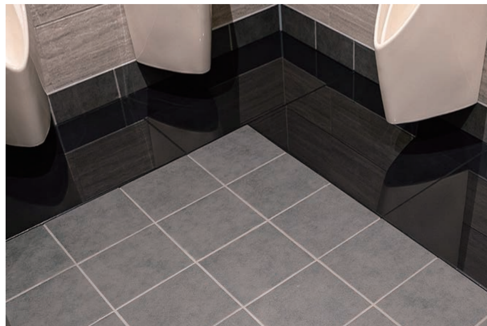
小ホール 男性用トイレ 内装壁・床タイル、汚垂れ石
