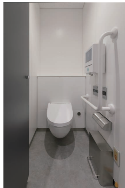
南側 女性用トイレ 大便器
