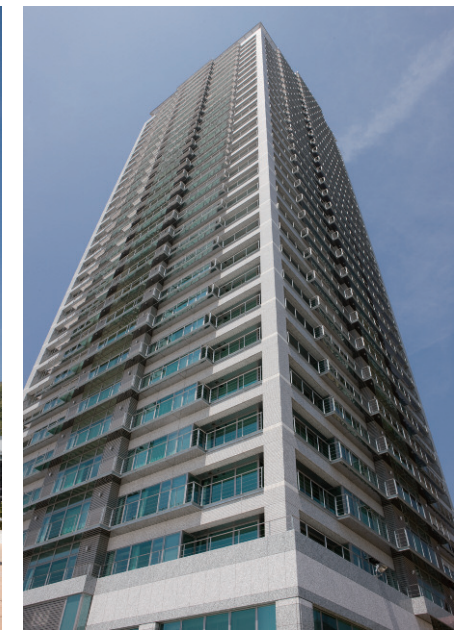
南東側見上げ
