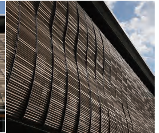
北西側/見上げ
