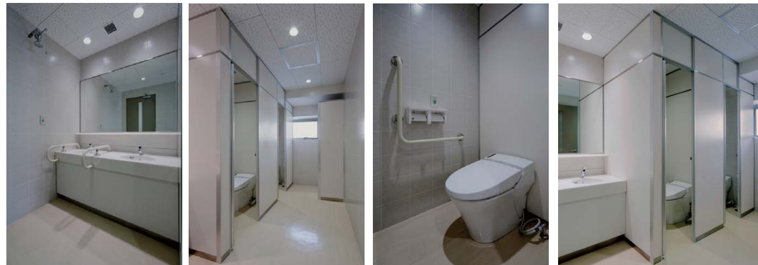
男女トイレの大便器には、6リットル洗浄による節水、便フタの閉め忘れを避けることによる節電で省エネに繋がる、フルオート便座機能付のサティスを採用。女性用トイレにおいては、呼び出しボタンの設置や天井までの高さのあるブースなど、安全面への配慮もなされている。
