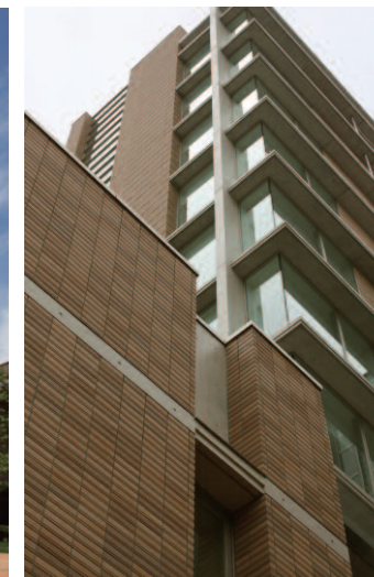
南東側/見上げ
