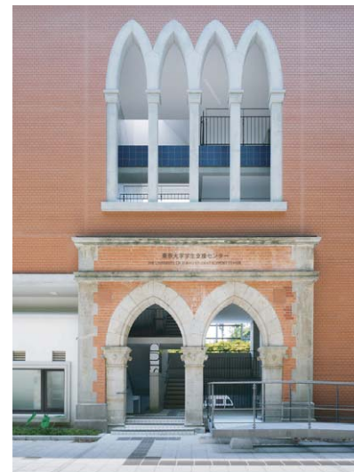
北側/正面入口
