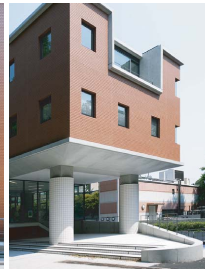
北西側/見上げ
