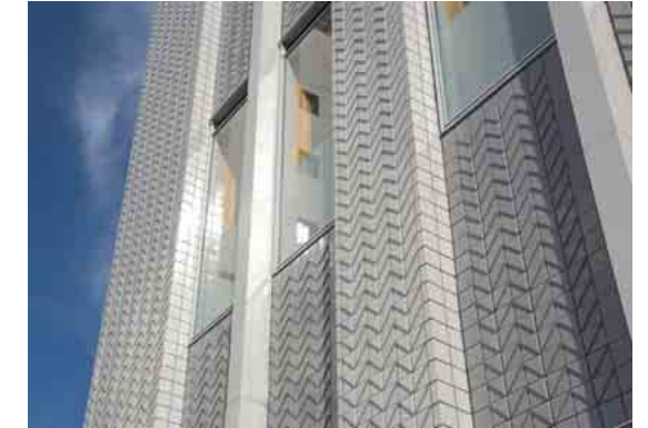
南東側見上げ
