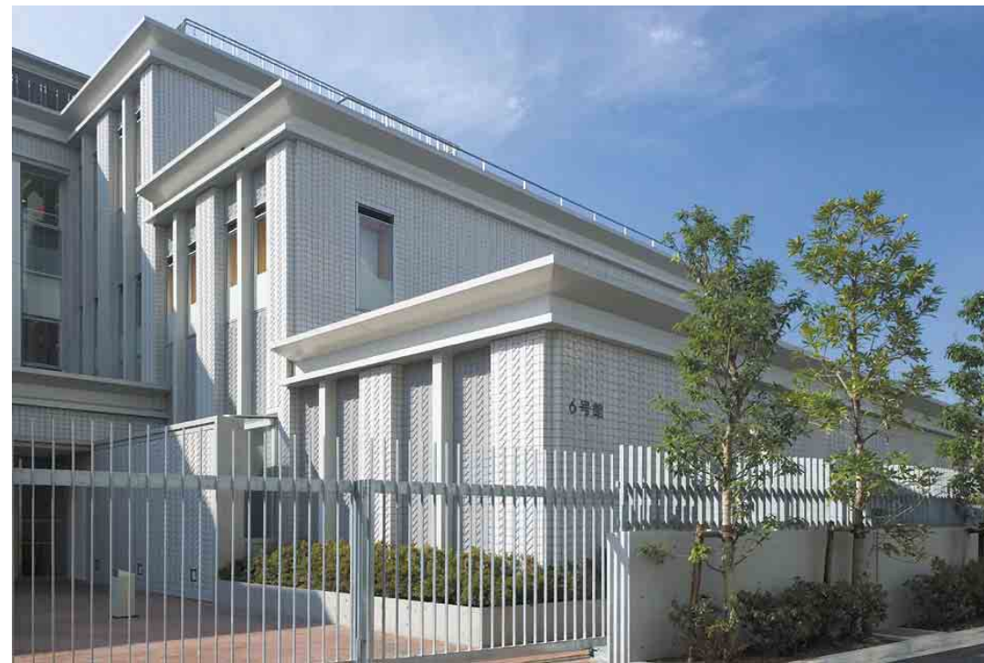
北東側見上げ
