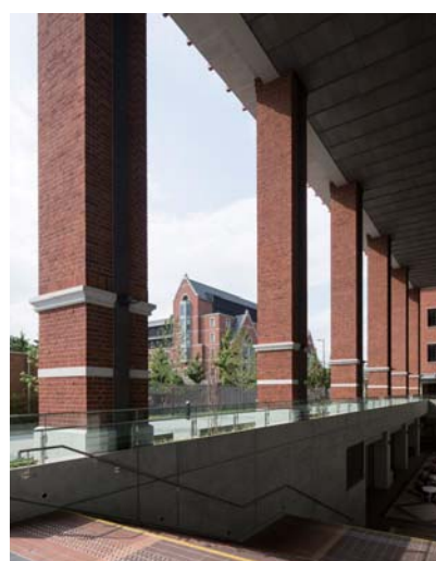
B1F 吹き抜け
