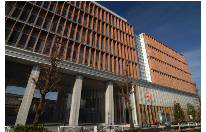
東側見上げ全景
