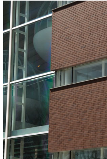
東側外壁面 右側
