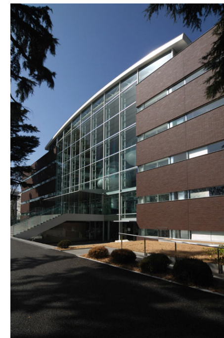
東側外壁面 右側
