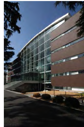
東側外壁面 右側
