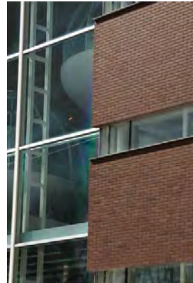
東側外壁面 右側
