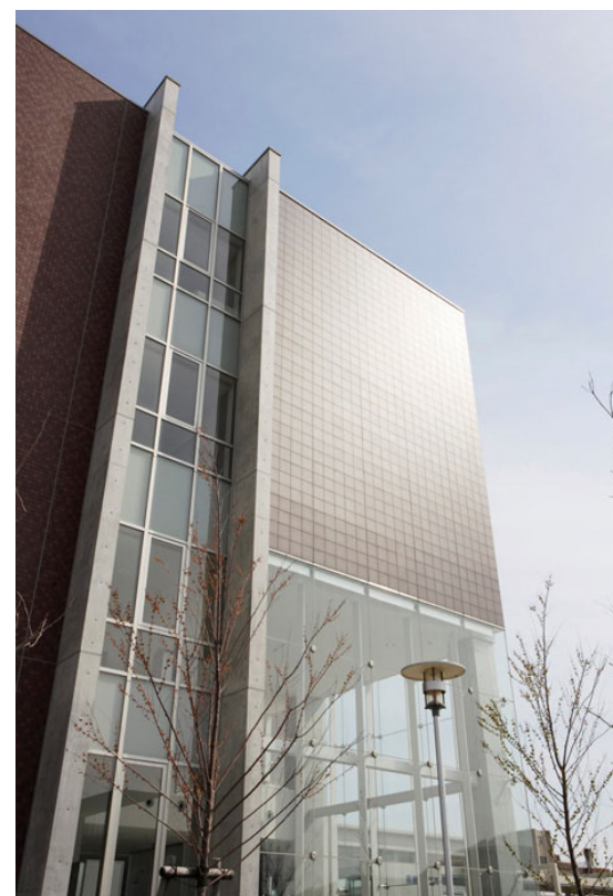
北東側見上げ
