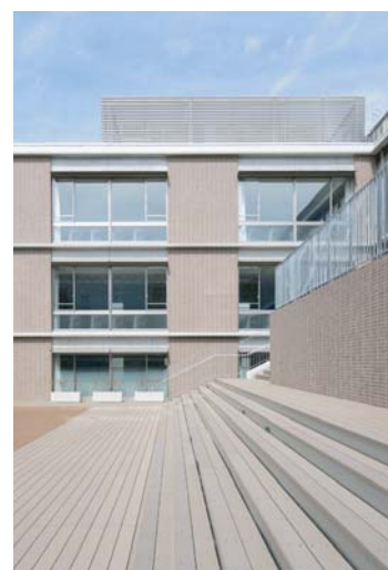
教室棟中庭全景
