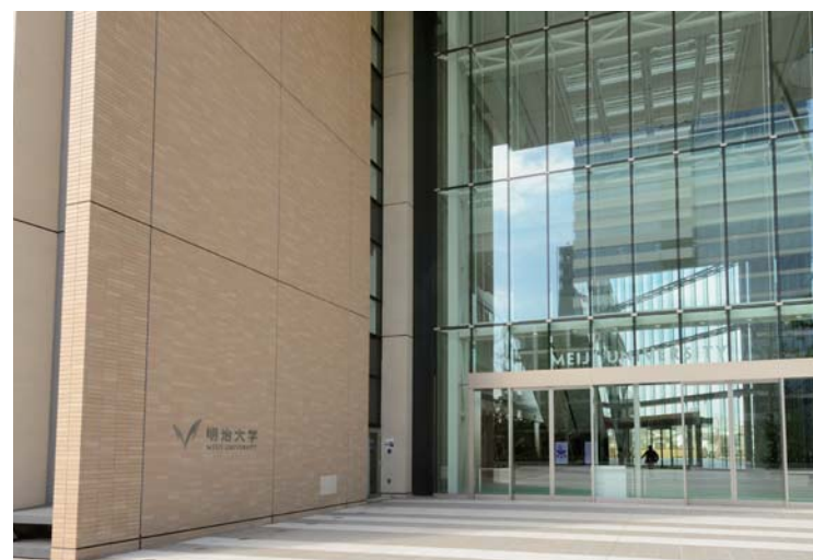
エントランス付近
