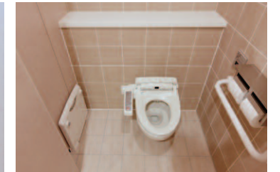
大便器ブース / チェンジングボード
