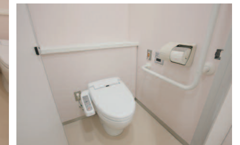
大便器ブース / 手すり
