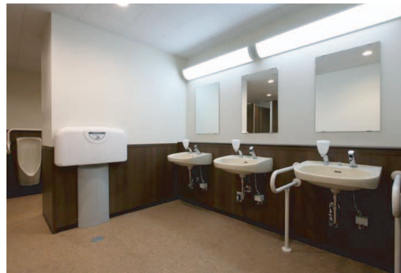
ダークな木目調の面材で落ち着いた空間に。男性用トイレの小便器は洗浄に水を使わない無水小便器を採用。男性用トイレにもベビーキープ・ベビーシートを設置し、ファミリーでの利用に配慮している。
