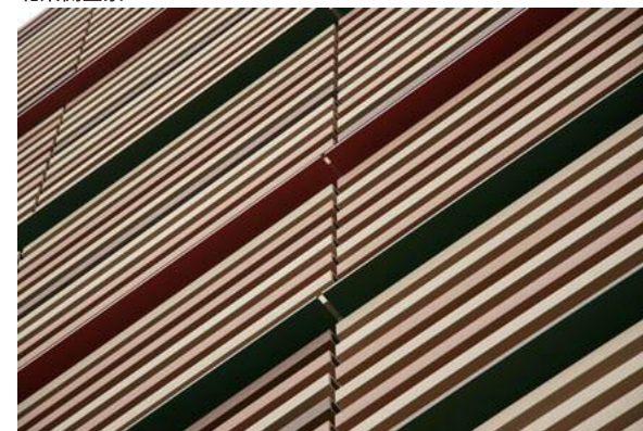
北西側見上げ
