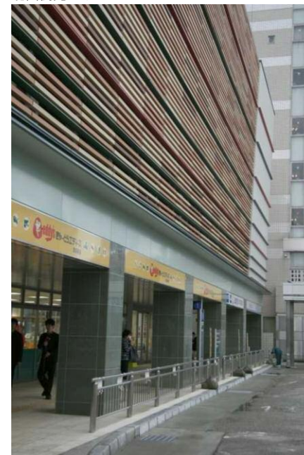
北東側見上げ
