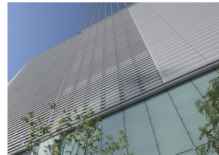
テラコッタルーバー見上げ
