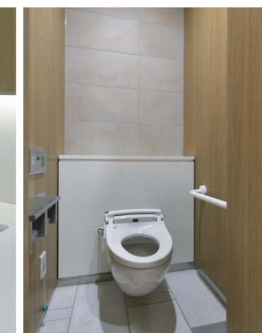
水栓金具は吐水空間が広く手を洗いやすいグースネック式。自動吐水とは別にスイッチで吐水を操作することができ、さらに湯と水の切り替えもできる高機能仕様。大便器は超節水ECO6・壁掛式タイプを採用。擬音装置は女性用トイレのみに設置。また、L型手すりを備えたブースを男女各1ヶ所ずつ設け、様々なユーザーに配慮。
