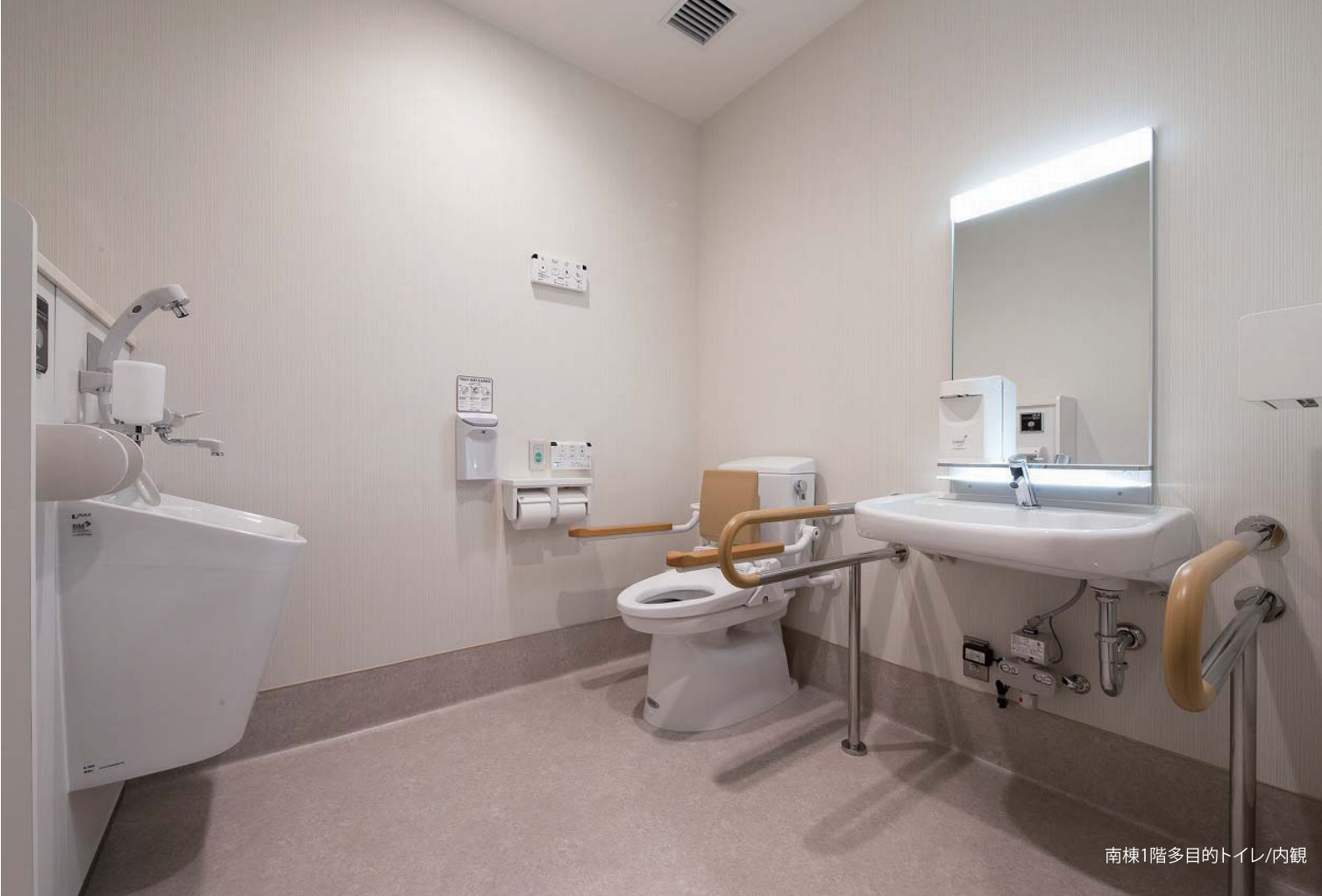
多目的トイレはオストメイト対応器具も備えたフルスペック仕様。男女トイレは節水タイプの便器・自動水栓を採用し、環境に配慮している。
