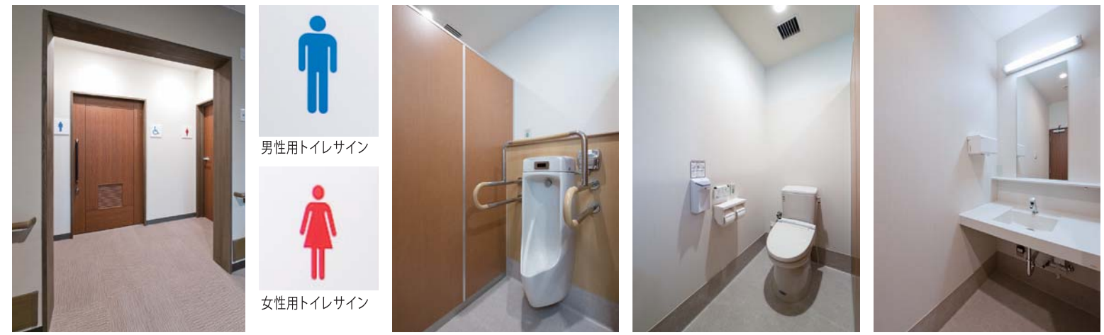
多目的トイレはオストメイト対応器具も備えたフルスペック仕様。男女トイレは節水タイプの便器・自動水栓を採用し、環境に配慮している。
