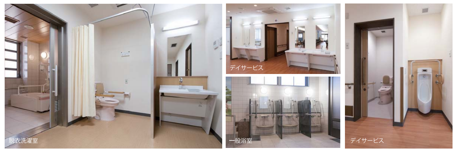
脱衣室は介助し易いよう、トイレの仕切りをカーテンとした。浴室には一定の温度で安全に利用できるサーモスタット水栓を採用。食堂には車椅子でも利用し易い洗面カウンターを集中利用に配慮して4台設置。
