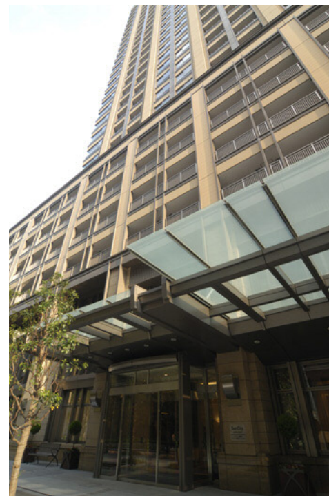
エントランス入口
