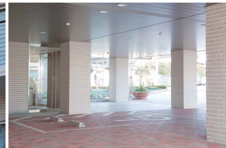
1F エントランス入口
