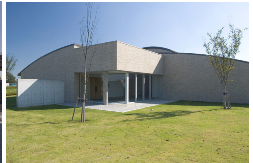
北東側待合室入口
