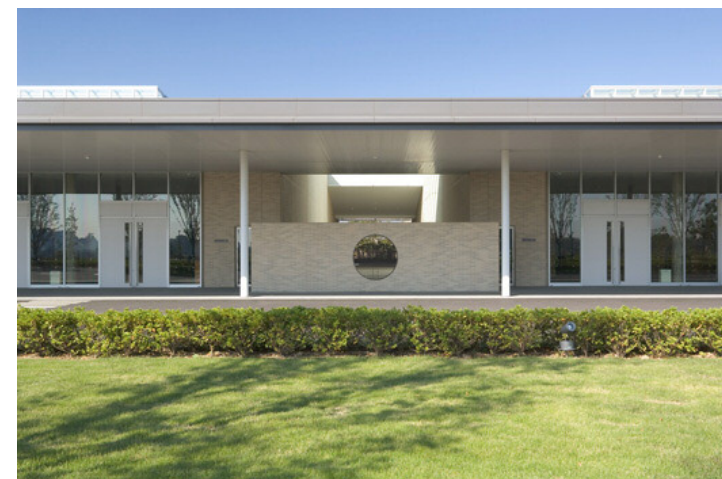
西側斎場吹き抜け部
