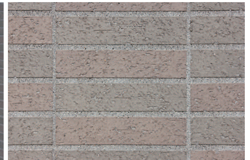
タイルディテールアップ (目地幅:縦5mm×横8mm)
