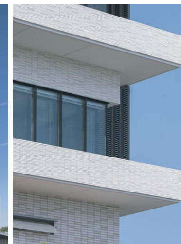
外装壁(南東角面)中景
