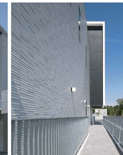
外装壁(東面)近景
