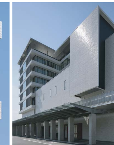
外装壁(東面)中景
