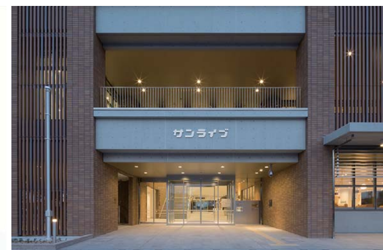
エントランス外装壁面
