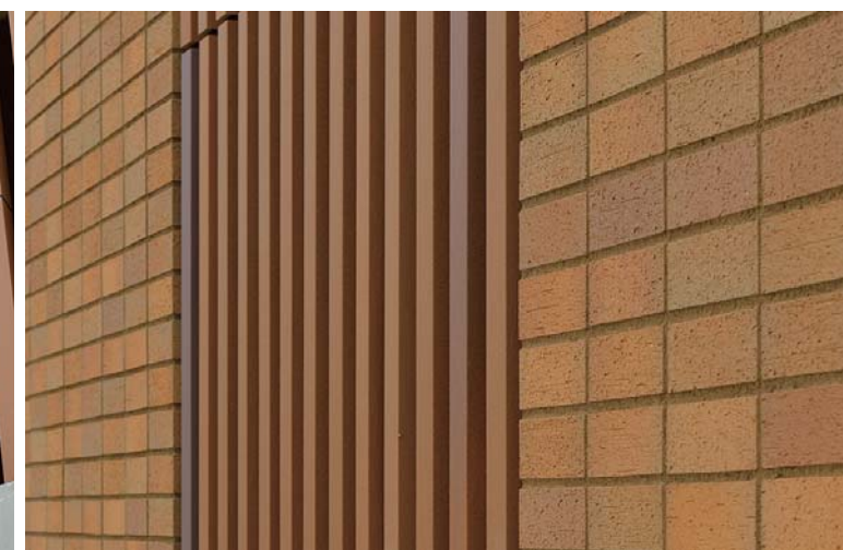
外装壁タイル面ディテール
