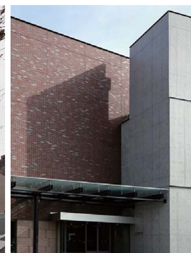
エントランス外装壁面
