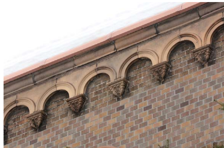
外装壁面(パラペットテラコッタ+タイル)
