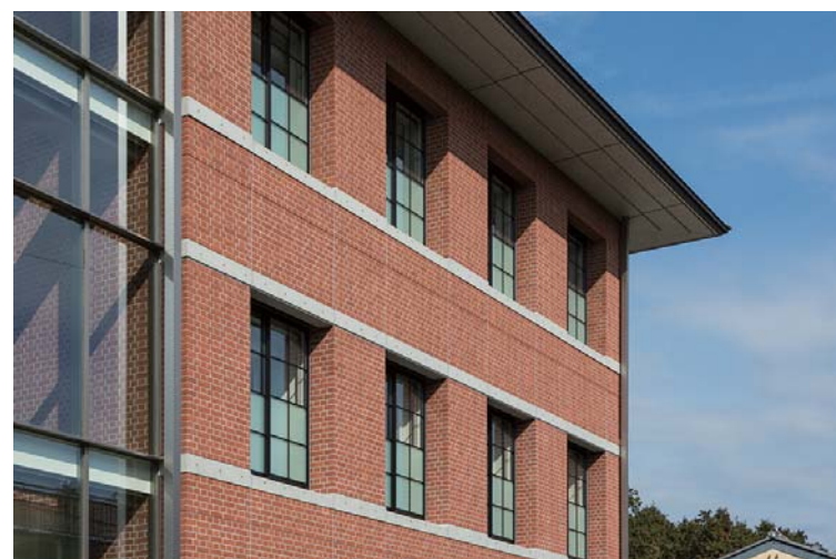
東南側から見上げ
