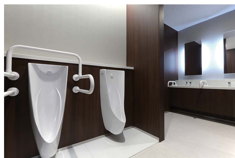
意匠性と使いやすさを両立した小便器は、壁掛式で床の清掃がしやすく、シンプル形状で凹凸が少ないためツルツと一拭きできるようになっている。また小便器下には尿だれに配慮した汚垂石を設置。洗面カウンター・小便器・大便器エリアには、利用者が安心して利用できるようそれぞれに手すりを備えている。
