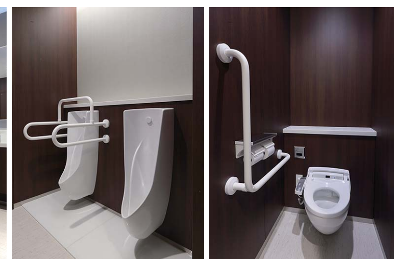
意匠性と使いやすさを両立した小便器は、壁掛式で床の清掃がしやすく、シンプル形状で凹凸が少ないためツルツと一拭きできるようになっている。また小便器下には尿だれに配慮した汚垂石を設置。洗面カウンター・小便器・大便器エリアには、利用者が安心して利用できるようそれぞれに手すりを備えている。
