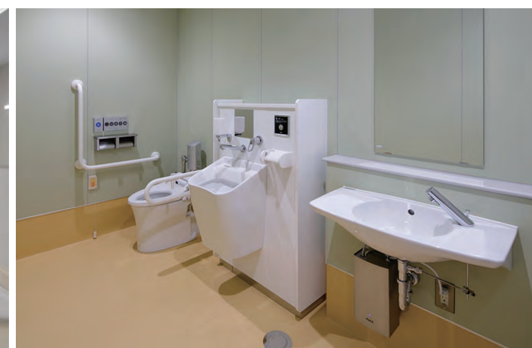
管理棟 多機能トイレ
