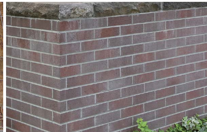
外溝擁壁部外装壁面ディテール
