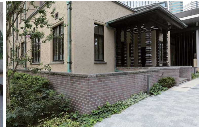
外溝擁壁部外装壁面
