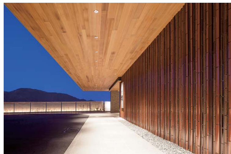
エントランス外装壁面
