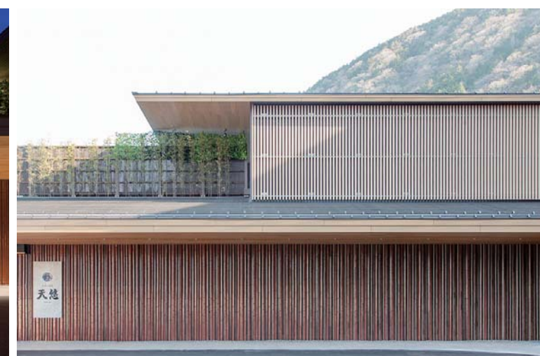
エントランス外装壁面
