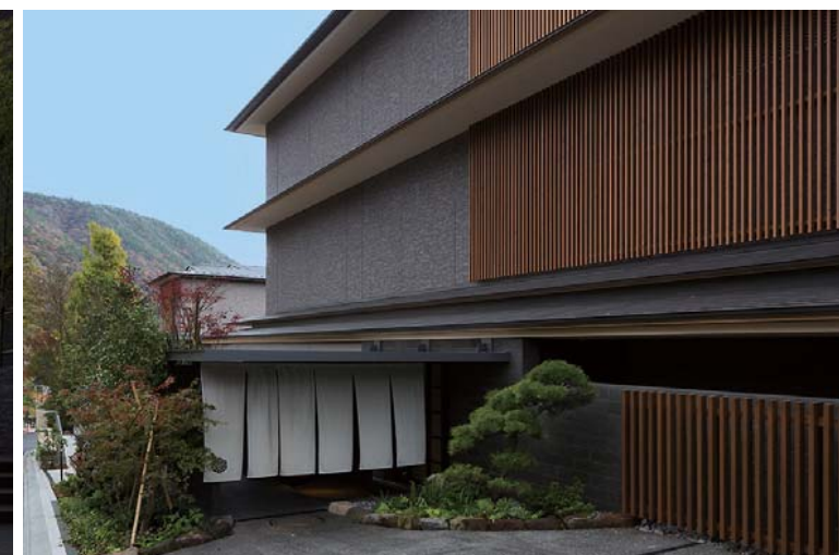
外装壁面北面
