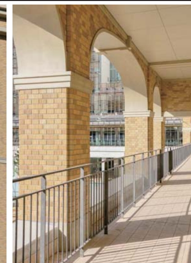
南西側2階デッキ
