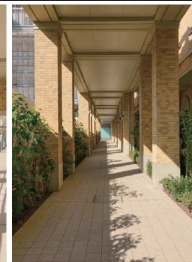
南西側1階デッキ下通路
