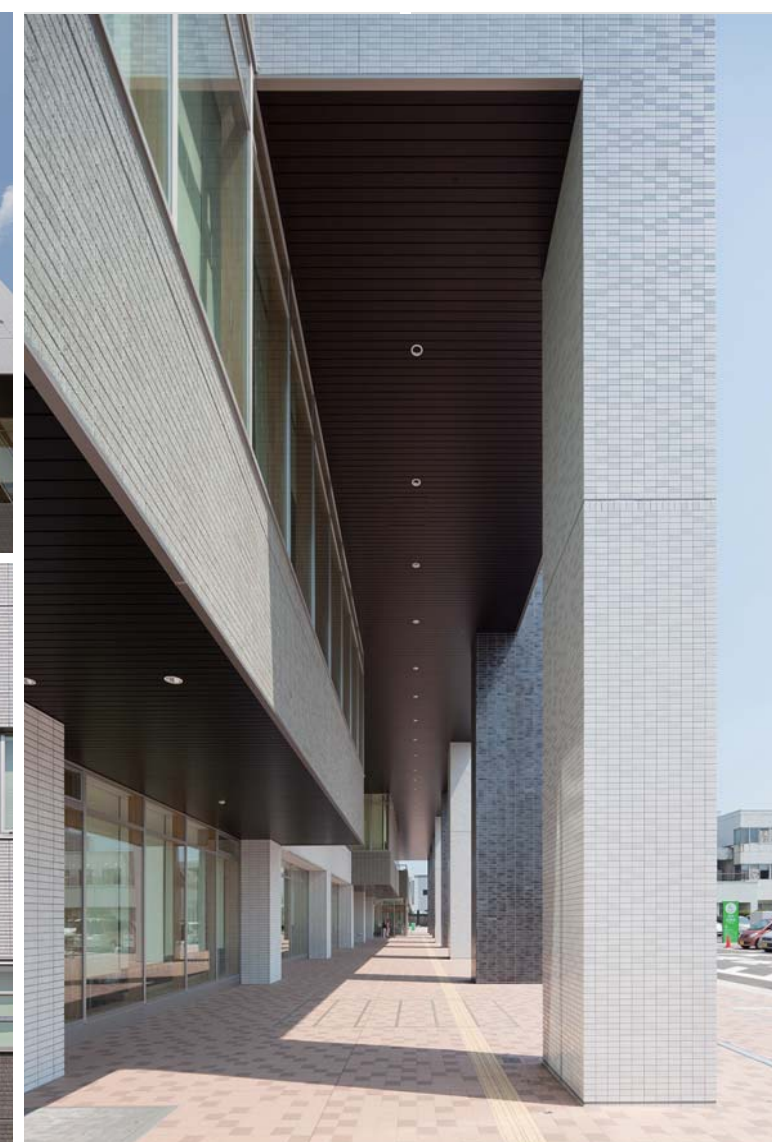
病院棟外装柱まわり
