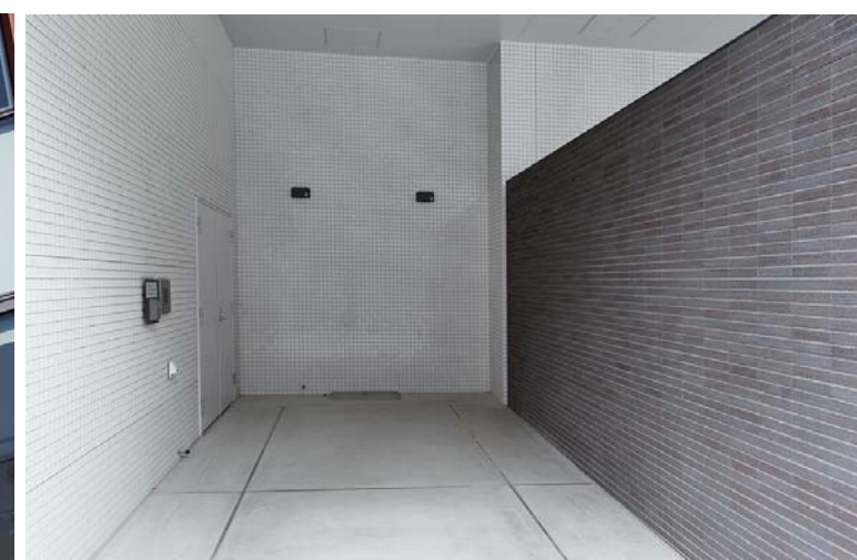
霊安室外装壁面
