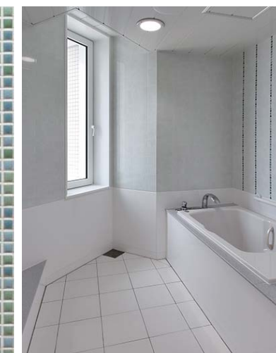
浴室内装壁床面タイル
