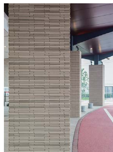
シェルター外装壁面タイル
