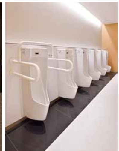
トイレ内装床面(汚垂石)
