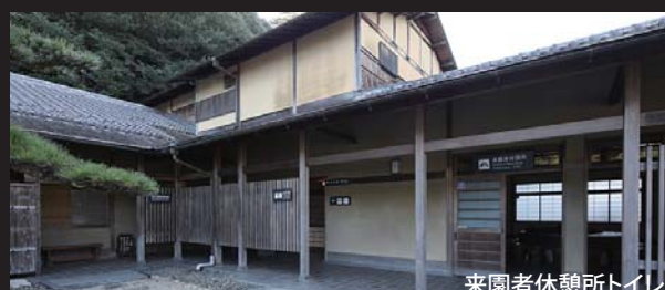
来園者休憩所トイレ
